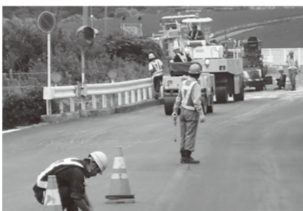
県道の拡幅工事に伴う舗装工事。拡幅は来年以降 (江奈湾全域図⑩)
