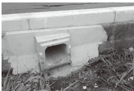
拡幅工事に先立って設置された要望とは異なる形状の函渠(江奈湾全域図⑨)
