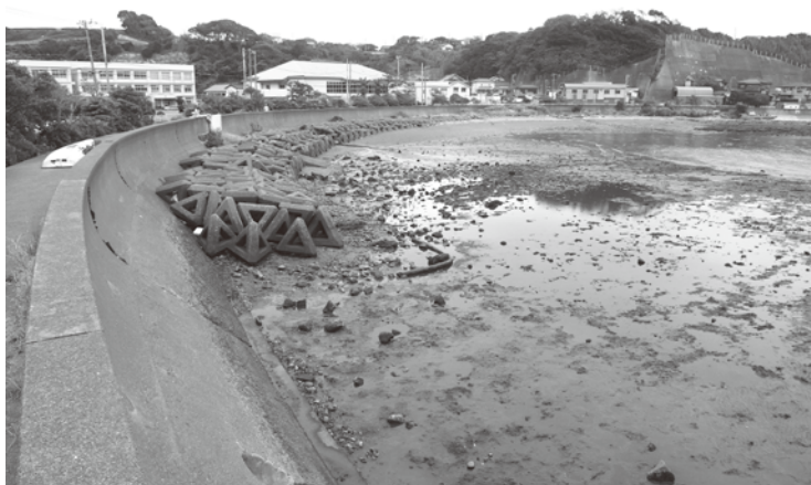
堤防に囲まれた砂礫干潟。左奥は剣崎小学校 (江奈湾全域図⑤)
