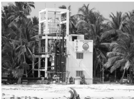
写真1 日量100トンの淡水化装置
