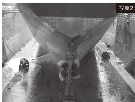
ドックでの船体汚損生物の除去作業
