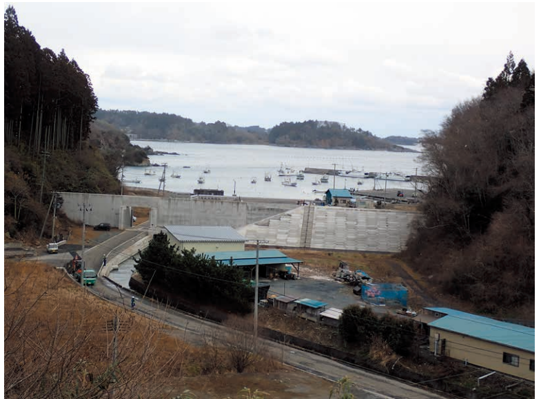
写真10 防潮堤をセツバックして建てたので、逆に高台からは浜の様子が手に取るように見える(南三陸町歌津、2025.1.15)
