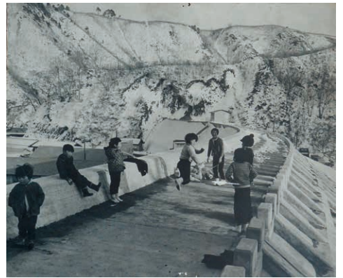
写真6 防潮堤の小屋に飾られていた、子どもたちが縄跳びをしている写真
